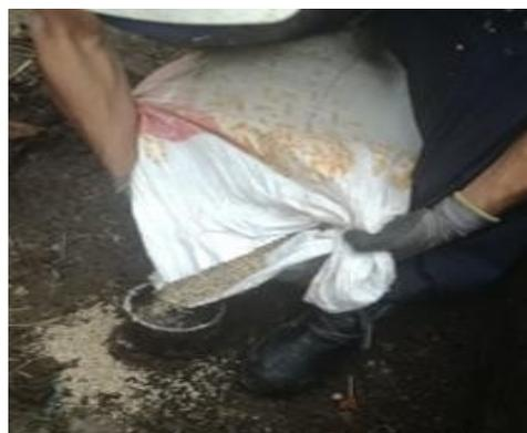
**Fotografía 4.** Uso de grava para rellenar las 2/3 Partes de la tubería de revestimiento.
