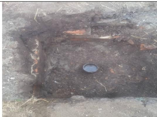
**Fotografía 3.** Excavación de 1X1 metro y 50 cm de profundidad alrededor del pozo.
